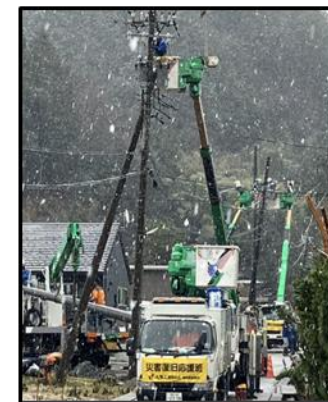
地震により傾いた電柱の建替作業
