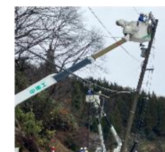
設備健全性に関する診断 高所・充電部近傍での作業 送配電設備に関する知識
