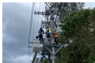
設備健全性に関する診断 高所・充電部近傍での作業 送配電設備に関する知識
