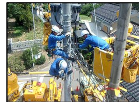
公道における電線工事
