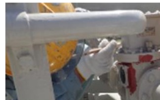
充電部近傍での作業 送配電設備に関する知識
