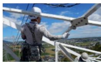
設備健全性に関する診断 高所・充電部近傍での作業 送配電設備に関する知識
