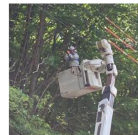
高所・充電部近傍での作業
