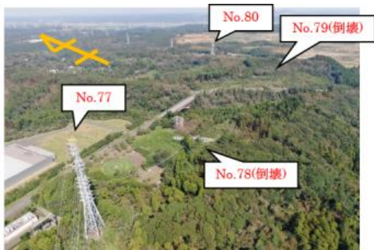
木内線No.78、No.79損壊全景 （東京電力PG）
