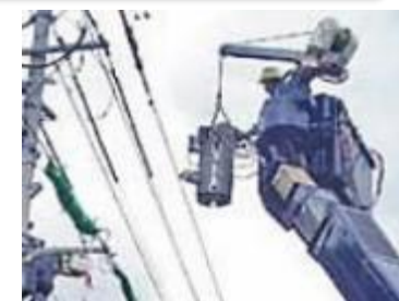
例) 柱上変圧器取替
