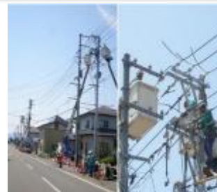
例) 新柱への設備移設
