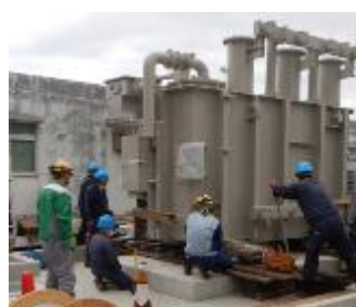
例) 変圧器設置
