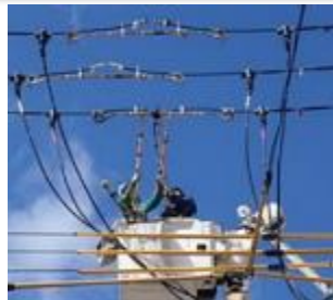
例) バイパスケーブル取付
