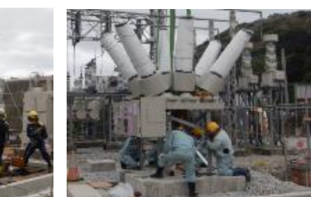
例) 遮断器設置
