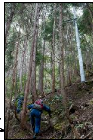
山間部の地上巡視
