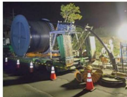
ドラム場・エンジン場設置 ケーブル布設・接続工事等
