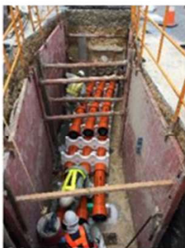
掘削・管路布設 埋戻し等
