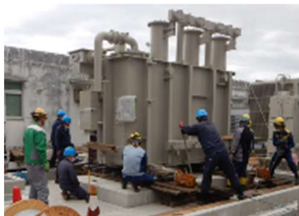
例) 変圧器設置
