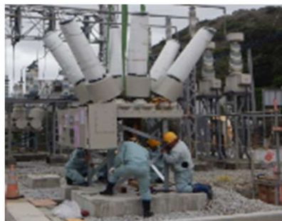
例) 遮断器設置
