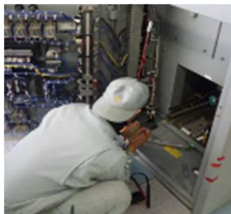
例) 制御ケーブル工事
