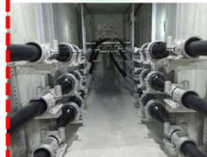
写真：人孔内部（接続部）
