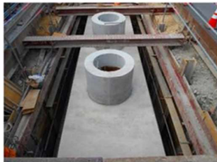
掘削・配筋・コンクリート打設等 (プレハブ式：現場搬出・組み立て)
