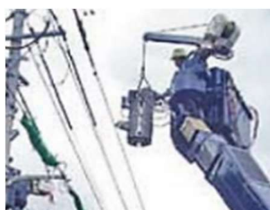
例) 柱上変圧器取替
