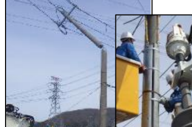
災害時連携計画で定めた電柱 折損仮復旧(中間部折損)訓練
