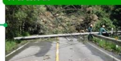
災害時連携計画で定めた電柱折損仮復旧(中間部折損)訓練
