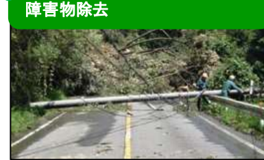
災害時連携計画で定めた電柱 折損仮復旧(中間部折損)訓練
