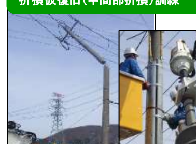
災害時連携計画で定めた電柱 折損仮復旧(中間部折損)訓練
