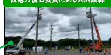
他電力復旧要員による共同訓練
