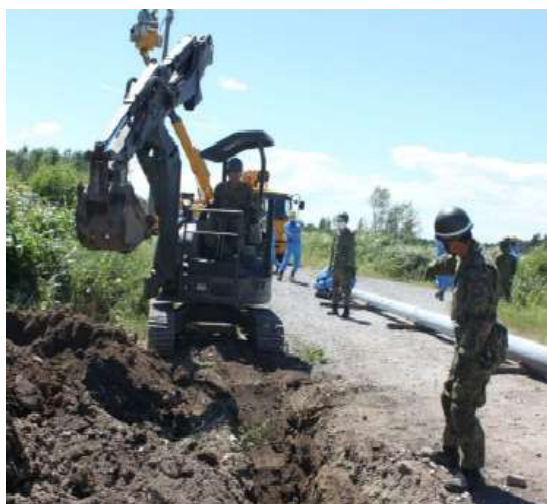
電柱建て込み場所の掘削作業
