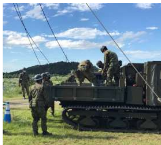
不整地運搬車による変圧器運搬
